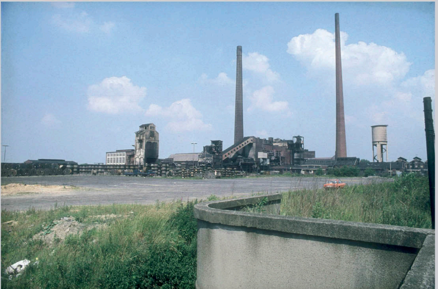
OBE N : Zeche Lothringen, Abbruch eines Förderturms, 1980 UNTE N : Zeche Lothringen IV (Hiltrop) vor dem Abbruch, 1970er
